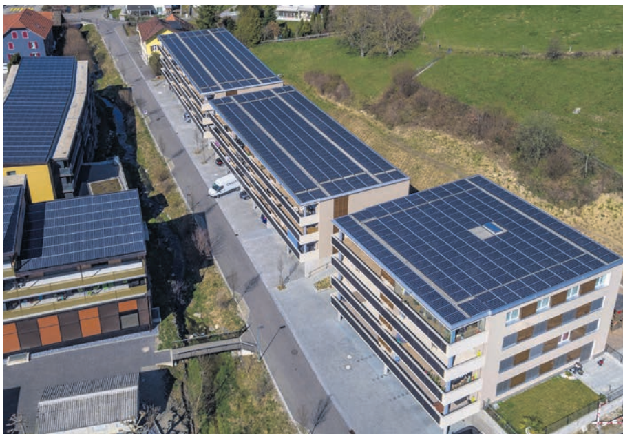
Abb. 2: 182%-PlusEnergie-Siedlung, 9555 Tobel/TG. 32 Wohnungen werden vollständig solar versorgt. Dazu kommt ein Stromüberschuss der ausreicht, um 77 E-Autos je 12 000 km CO 2 -frei fahren zu lassen. Die Mietzinse sind 20% niedriger als vergleichbare Wohnungen in der Region.
