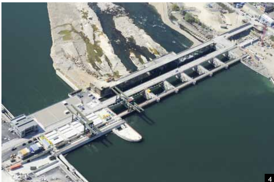
Abb. 4: Allein die vorbildliche Sanierung des WKW Rheinfelden erbringt mehr Strom als die geplante Zerstörung der 10 schönsten Flusslandschaften von nationaler Bedeutung wie der Greina.
