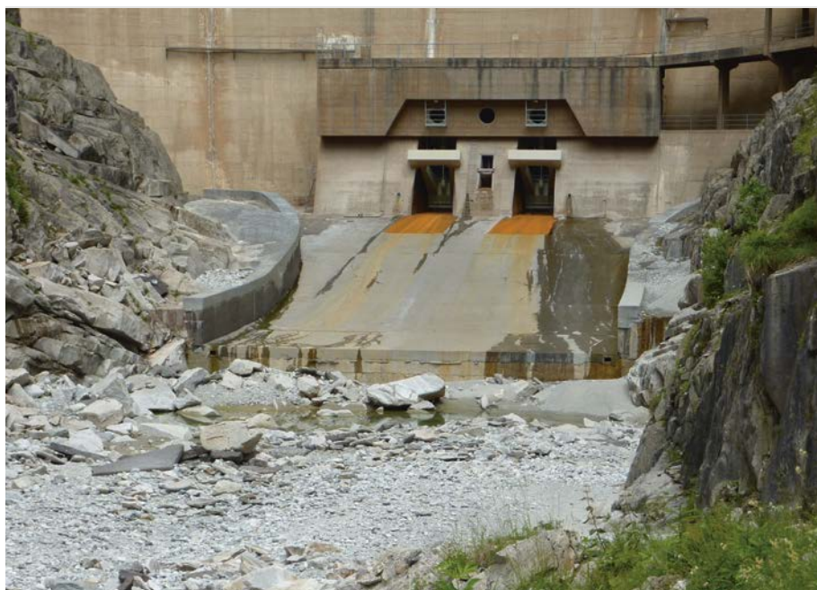
Der Walliser Bach Massa ist durch die Staumauer Gibidum beinahe trockengelegt. (© SGS)
