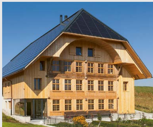
Abb. 4: Das 2015 sanierte 700 %-PEB-Doppeleinfamilienhaus Anliker von 1765 deckt 100 % des Gesamtenergiebedarfs von 13 000 kWh/a für zwei Wohnungen. Laut EW-Messungen erzeugt es rund 90'000 kWh/a. Mit dem CO 2 -freien Solarstromüberschuss können 55 E-Autos jährlich 12 000 km emissionsfrei fahren. Winterstrombedarf 8000 kWh/a – Winterstromproduktion: 21 000 kWh/a. PEB decken den Winterstrombedarf. Mit Minerlogie-P gedämmten Wohn- oder Geschäftsbauten, die bis 90 TWh/a reduzieren können, kann die angeblich «grosse Winterstromlücke» von 6 TWh/a 15 Mal eliminiert werden!
