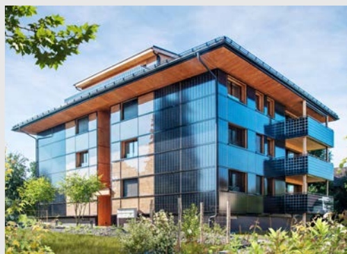
Abb. 1: Dank optimaler Dämmung benötigt der PlusEnergieBau 113000 kWh weniger Strom pro Jahr. Mit den Photovoltaik (PV)-Dach und PV-Fassadenanlagen wird ein Energieüberschuss von 53000 kWh pro Jahr produziert.
