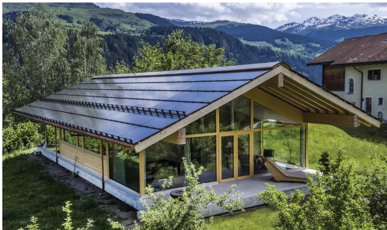
Abb. 4c: Das 2019 in Waltensburg/GR erstellte PEB-Einfamilienhaus Brunner-Bapst produziert jährlich 40'200 kWh. Dank Minergie-P-Dämmung benötigt es nur 4'900 kWh/a . Die 817%-Eigenenergieversorgung sorgt für einen Stromüberschuss von 35'200 kWh/a . Die Energiewende und das Pariser Klimaabkommen werden mehrfach erfüllt und übertroffen (Schweizer und Norman Foster PEB Solarpreis 2020; S. 26-34). \approx 380% Winterstromversorgung
