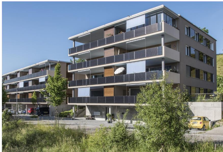
Abb. 4b: 182% PEB Siedlung, 32 Wohnungen, Tobel/TG deckt 100% des Gesamtenergiebedarfs, generiert dazu einen Stromüberschuss von gut 106'000 kWh/a ; Mietpreise 20% günstiger im Vergleich mit gleichwertigen Wohnungen. Winterstromversorgung \approx 85% mit PV-Ost-Westfassaden \approx 115% Winterstromsicherheit
