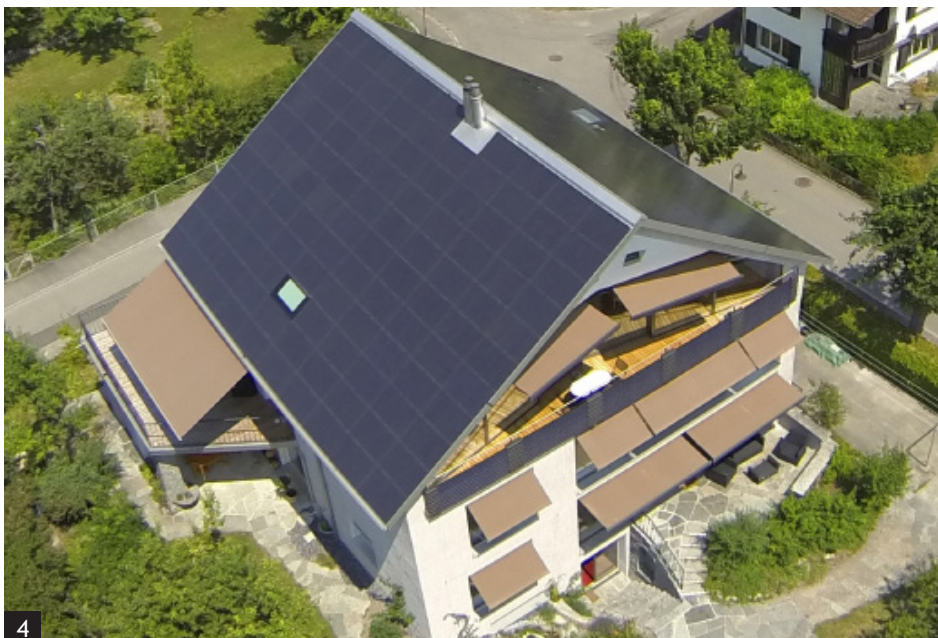
Abb. 4: Das 1947 errichtete und mit dem Schweizer Solarpreis 2013 ausgezeichnete Mehrfamilienhaus in Thun/BE konsumierte bisher fast 80'000 kWh/a. Seit der Sanierung benötigt es noch 20'600 kWh/a - und erzeugt 38'500 kWh/a Solarstrom. Die Eigenversorgung beträgt 187%, obwohl die Anzahl Wohnungen von 2 auf 3 und die Energiebezugsfläche um 38% zunahm. (Bild: Solar Agentur Schweiz)
