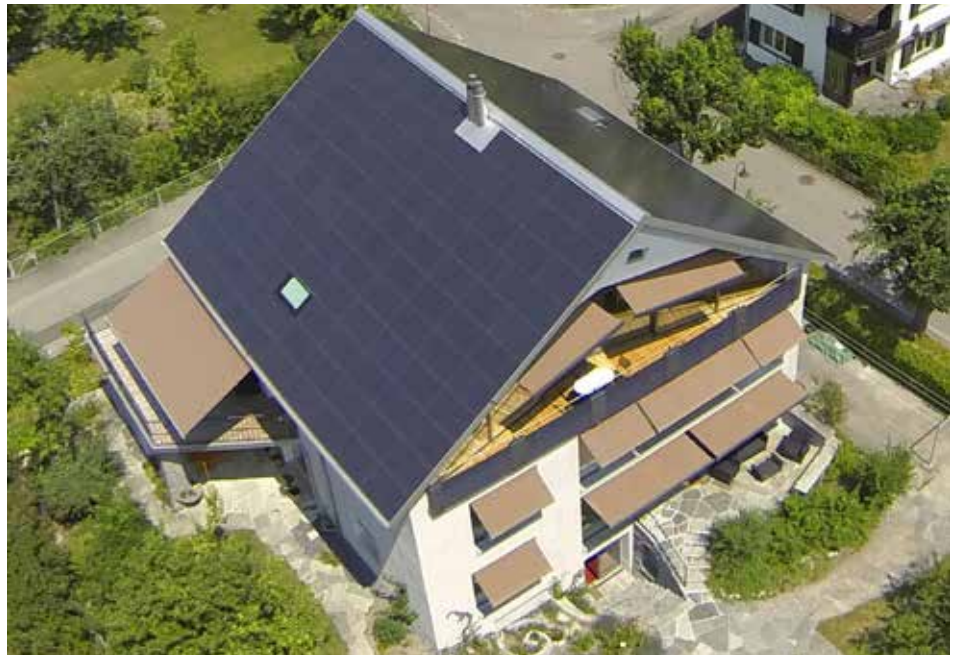
Abb. 3: Das mit dem Schweizer Solarpreis 2013 ausgezeichnete Mehrfamilienhaus in Thun/BE konsumierte vor der Sanierung fast 80'000 kWh/a. Heute benötigt es noch 20'600 kWh/a - und erzeugt 38'500 kWh/a Solarstrom. Die Eigenversorgung beträgt 187%, trotz Ausbau von 2 auf 3 Wohnungen. (Bild: Solar Agentur Schweiz)
