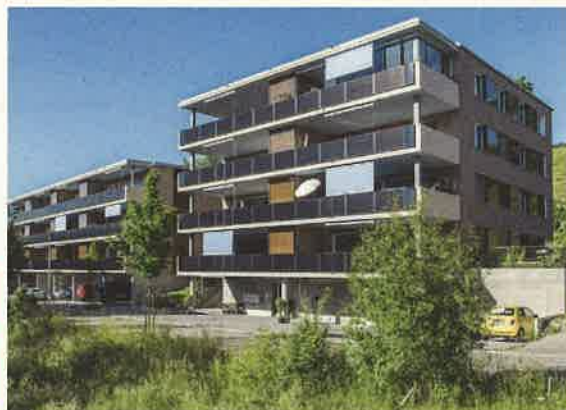
Abb. 3: Die 182% PEB Siedlung mit 32 Wohnungen, Tobel/TG deckt mit 129 500 kWh/a 100 % des Gesamtenergiebedarfs. Sie produziert insgesamt 236'300 kWh/a , davon einen Stromüberschuss von gut 106 000 kWh/a . Damit können 76 E-Autos jährlich je rund 10000 km CO 2 -frei fahren. Die Mietpreise sind 20 % günstiger im Vergleich zu gleichwertigen Wohnungen in der Region. Winterstromversorgung ≈ 85% – mit PV-Ost-Westfassaden ≈ 115 % Winterstromsicherheit .
