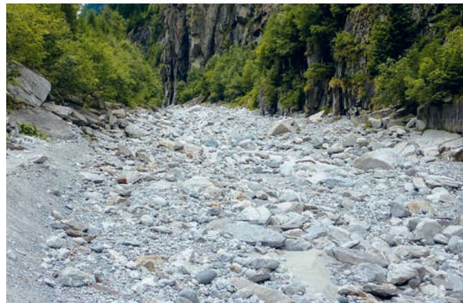
Abb. 3: Nach der Staumauer des Massastausees (VS) lassen die Electras Massa SA kaum Restwasser fließen (© SGS)
