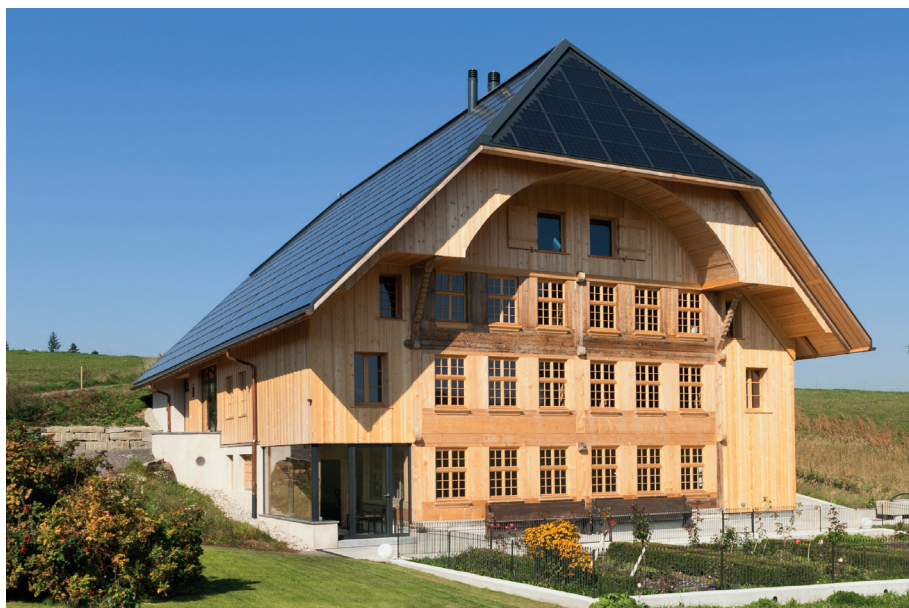
Das renovierte Anliker-Doppelfamilienhaus von 1765(!) erzeugt 3,5 Mal mehr Energie, als es jährlich braucht. (© SAS)
