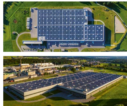
Abb. 1b: Logistikzentrum Perlen LU. Die 6,4 MW starke PV-Anlage produziert jährlich 7,3 Mio kWh und benötigt 3,1 Mio kWh pro Jahr. Mit dem emissionsfreien Solarstromüberschuss können 3000 E-Autos jährlich je 10 000 km fahren; mit dem gesamten Solarstrom können ca. 5000 E-Autos CO 2 -frei fahren.
