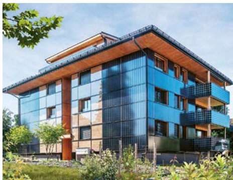
Abb. 1a: PEB-Sanierung 7-Fam.-Haus Fahrwangen AG. Dank optimaler Dämmung sank der Energieverbrauch pro Jahr von 138 000 kWh um 82 % auf 25 000 kWh. Das PEB-MFH erzeugt 78 000 kWh Solarstrom. Damit können das PEB-MFH und 2 E-Autos pro Wohnung CO 2 -frei versorgt und zusätzlich 21 000 kWh mittels PSKW für Winterstrom hochgepumpt werden.
