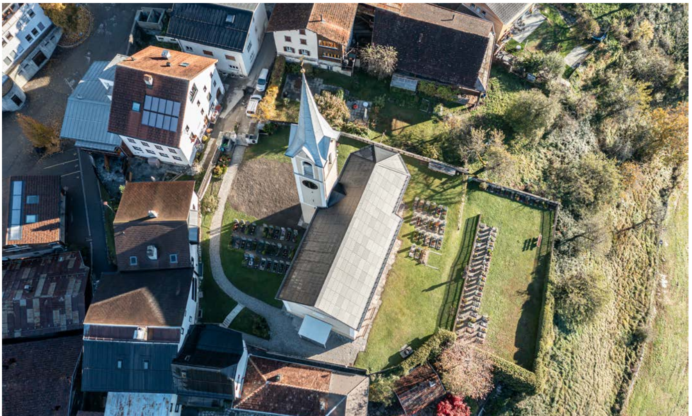
Abb. 2: Die reformierte 185% PlusEnergie-Kirche in Trin mit Baujahr 1491 ist ein leuchtendes Beispiel für einen nachhaltigen und umweltbewussten Energiehaushalt. Mit der ganzflächigen solaren Dachnutzung der Nord-, Ost-, und der PV-Südanlage von insgesamt 38,3 kWp generiert die Trinser Kirche rund 36800 kWh. Damit wird der Gesamtenergieverbrauch von 19900 kWh zu 185% CO 2 -frei gedeckt. Mit dem Solarstromüberschuss von 16900 kWh könnten zusätzlich noch je 11 E-Autos jährlich 10000 km emissionsfrei fahren.
