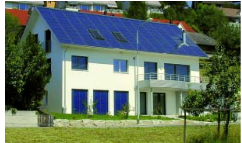
Das Wohnhaus der Familie Erni in Untersiggental erzeugt allein auf der Süddachfläche durchschnittlich 10'000 kWh Solarstrom pro Jahr. Rund 2'500 kWh/a werden ans öffentliche Netz geliefert.
