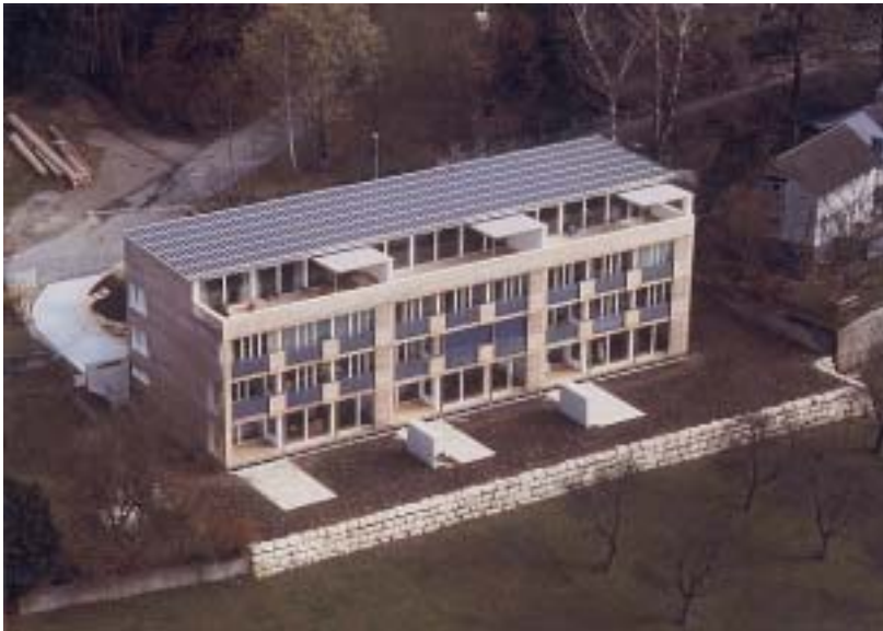
Das 6-Familienhaus "Sunny Woods" in Zürich deckt 100% des Heiz- und Warmwasserbedarfs mittels Sonnenenergie.
