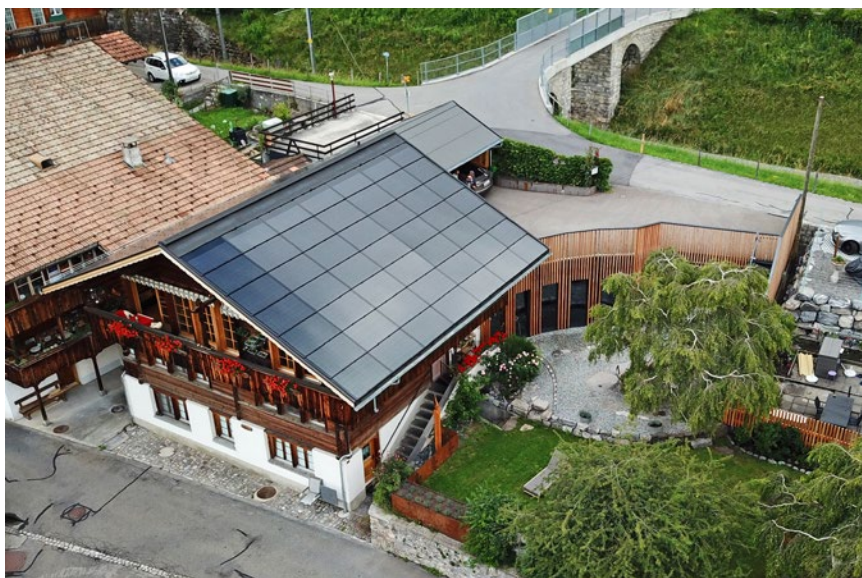
Abb. 5: Das vorbildlich sanierte 222%-PlusEnergie-EFH in Brienz/BE reduzierte dank guter Dämmung 80% Energieverluste. Die vorbildlich integrierte PV-Anlage produziert 24'129 kWh/a bei einem Gesamtenergieverbrauch von 10'850 kWh/. Daraus resultiert ein hoher Solarstromüberschuss von über 13'200 kWh/a. Damit können 9 E-Autos je 12'000 km pro Jahr emissionsfrei fahren.
