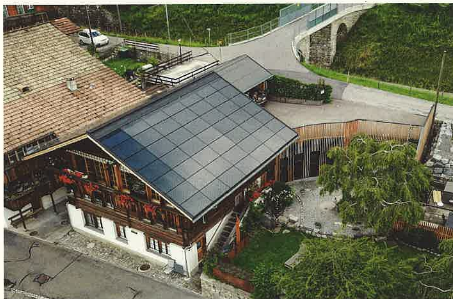
Abb. 4: Das vorbildlich sanierte 222%-PlusEnergie-EFH reduzierte dank guter Dämmung 80 % Energieverluste. Die vorbildlich integrierte PV-Anlage produziert 24 129 kWh/a bei einem Gesamtenergieverbrauch von 10 850 kWh/a. Daraus resultiert ein hoher Solarstromüberschuss von über 13 200 kWh/a. Damit können 9 E-Autos je 12 000 km pro Jahr emissionsfrei fahren.
