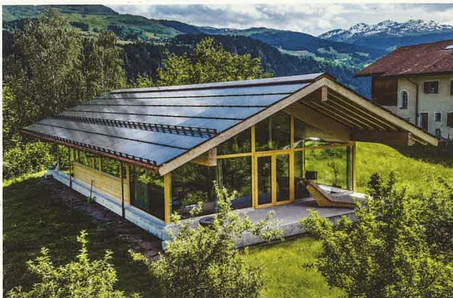
Abb. 3: 800 % CO 2 -freie Solarstromversorgung. Das Bauernhaus benötigt 5000 kWh/a und erzeugt gut 40'000 kWh/a. Mit dem CO 2 -freien Solarstromüberschuss können 25 E-Autos jährlich je 12 000 km emissionsfrei fahren.
