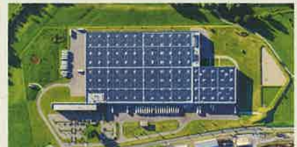
Abb. 4: Das perfekt integrierte Solardach des Logistikzentrums in Perlen/LU produziert jährlich 7.33 GWh – mehr als doppelt so viel wie es benötigt. Und mehr als 4 Kleinwasserkraftwerke (KWKW) . Mit dem Solarstromüberschuss können 3000 E-Autos jährlich 12'000 km CO 2 -frei fahren, mit dem gesamten Solarstrom sogar 5200 E-Autos. Dies entspricht der PW-Flotte einer Kleinstadt.
