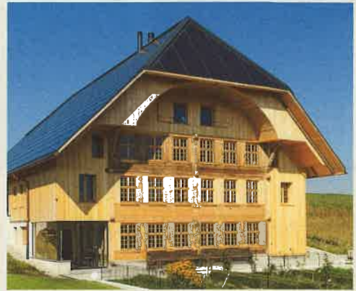
Abb. 3: Das 2015 sanierte 700 %-PEB-Doppeleinfamilienhaus Anliker von 1765 deckt 100 % des Gesamtenergiebedarfs von 13 000 kWh/a für zwei Wohnungen. Laut EW-Messungen erzeugt es rund 90 000 kWh/a. Mit dem CO 2 -freien Solarstromüberschuss können 55 E-Autos jährlich 12 000 km emissionsfrei fahren. Winterstrombedarf 8000 kWh/a – Winterstromproduktion: 21 000 kWh/a. PEB decken den Winterstrombedarf. Mit Minergie-P gedämmten Wohn- oder Geschäftsbauten können bis 90 TWh/a reduziert werden. Die angeblich «grosse Winterstromlücke» von 6 TWh/a kann somit etwa 15 Mal eliminiert werden!
